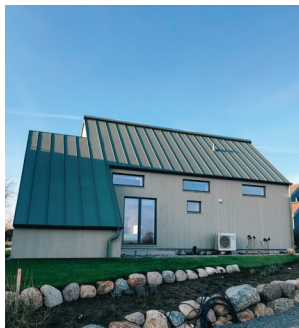
14 vakantiehuizen nabij het strand in Klützer Winkel (Duitsland)
