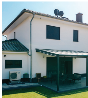
Nieuwbouw in Ertensee (Duitsland)
